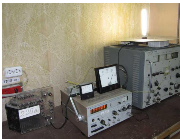
Рис. 2. Общий вид передающей части комплекса.
