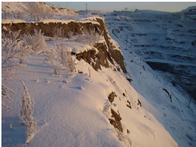
Рис.1. Вид на трещиномерную станцию №706 с развивающимся процессом смещения блока массива
